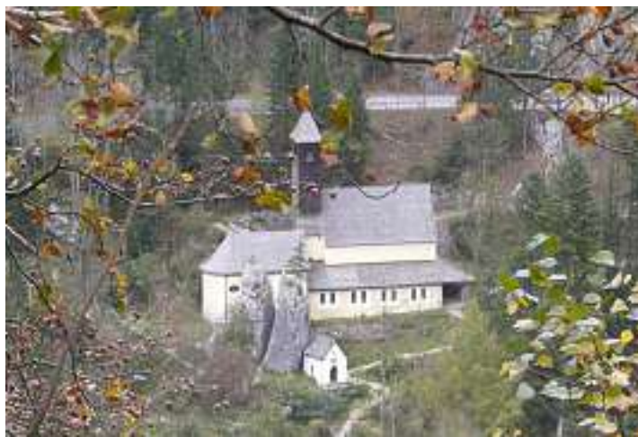
Abb. 4: Blick von oben auf die Marien-Wallfahrtskirche vom Klobenstein mit dem "geklobenen Stein" unterhalb der Pass-Straße von Schleching nach Kössen
